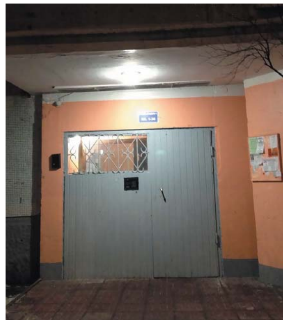
Рис. 8. Освещение входа в подъезд жилого дома светильником с лампой на основе СД мощностью 13 Вт
